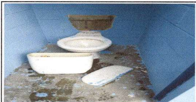
Foto 5: sustitución de inodoro
