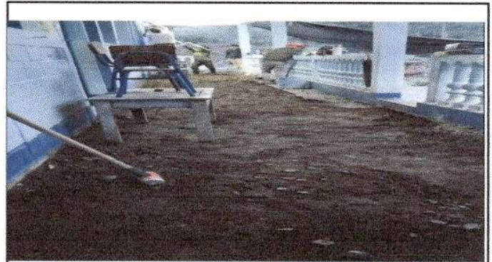
Foto 4: Sustitución piso ceramico
