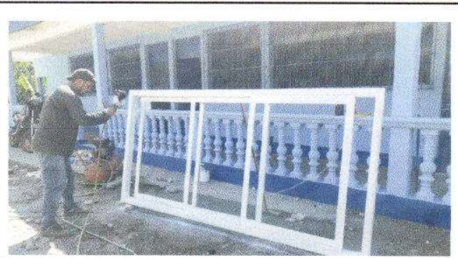
Foto 2: Sustitución de vidrios
